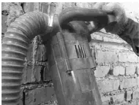
图 5-5 开横槽操作示意图
