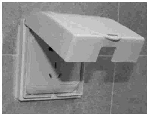
图4-7 防水防溅插座安装示意图
