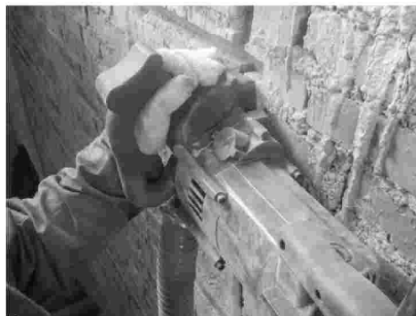
图 5-6 开竖槽操作示意图
