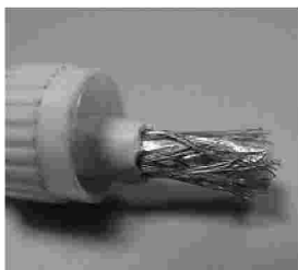
图 3-38 剥去电缆外层护套 图 3-39 屏蔽层取散、外折示意图 图 3-40 铝复合薄膜剪掉示意图
