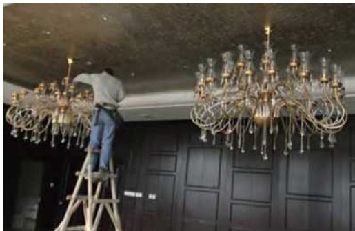
吊灯的底盘要安装牢固。
