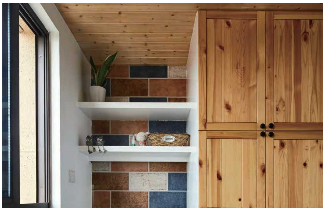
▲ 墙面柜体及吊顶均采用桑拿板，可以为阳台带来统一的视觉效果。
