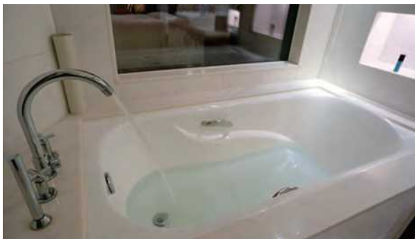
浴缸的排水系统安装。
