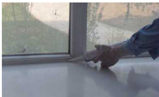
安装完成后的人造石需要打胶填缝。
