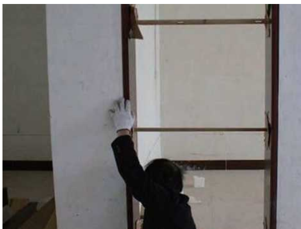
实木复合门的门套线安装。
