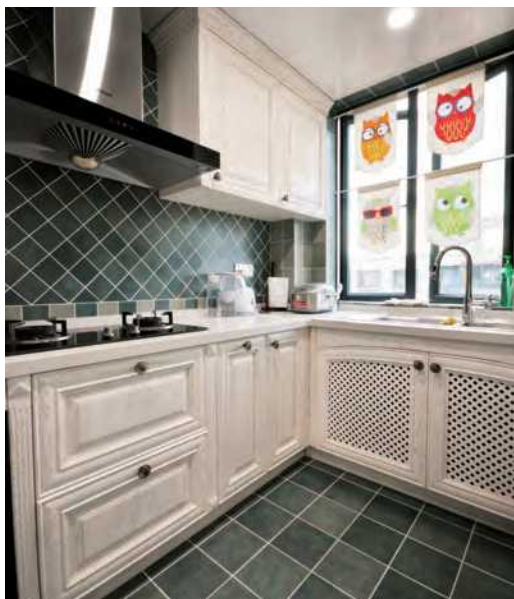
▲ 150mm×150mm 菱形铺贴的釉面墙砖与地砖形成视觉上的呼应，300mm×300mm 尺寸的釉面地砖比较适合小空间的厨房。
