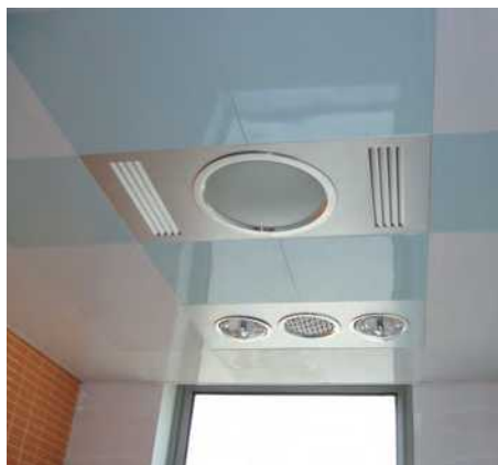
铝扣板的安装以基准线为标准。
