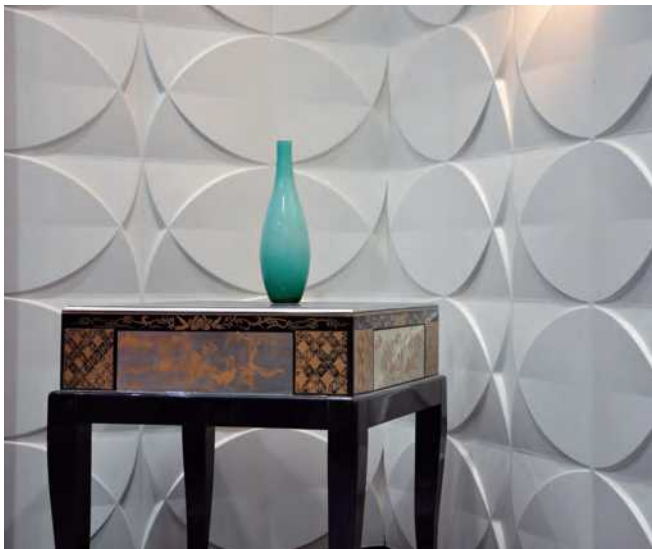
▲ 特殊造型的硅酸钙板隔墙既能装饰空间，又能起到隔音、防火的作用。
