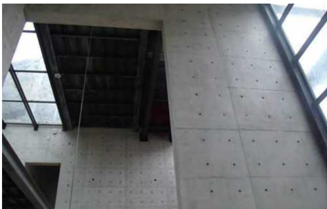
硅酸钙板墙面施工。
