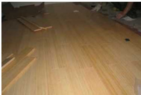
竹木地板的安装缝隙要严密。
