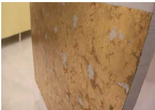
金属壁纸粘贴后表面平整、无气泡。
