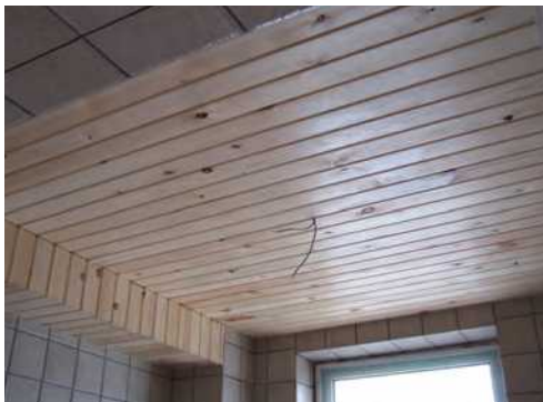
桑拿板吊顶要保证龙骨的稳固度。
