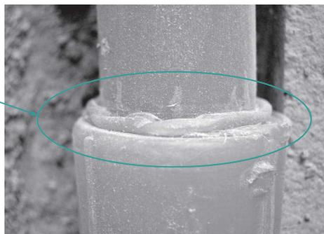
图1-23 PPR水管熔接“双眼皮”形状图示
