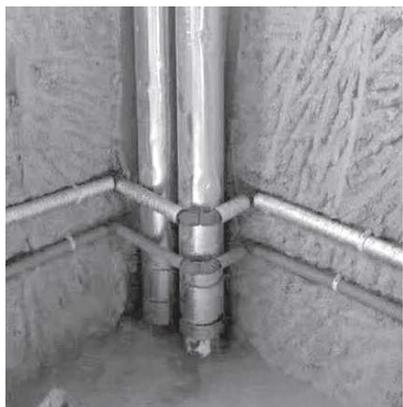
图1-24 给水管位于排水管外侧工艺
