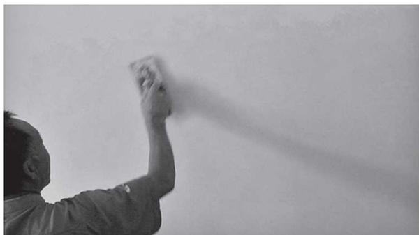
图4-5 用铁抹子压实压光面灰
