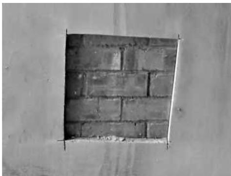
图10-5 砖基层水泥砂浆层
