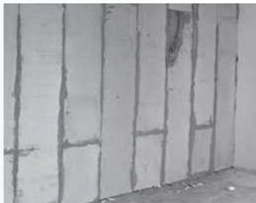
图2-17 某项目轻质板材隔墙工程
