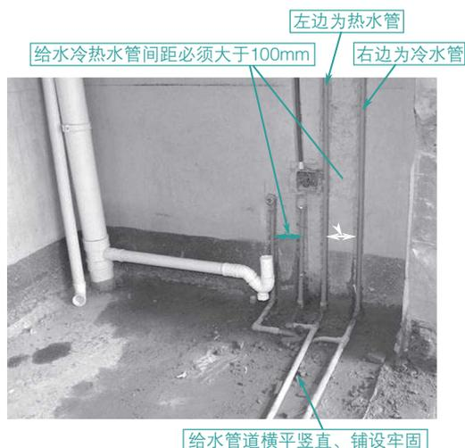
图1-43 左热管右冷管工艺
