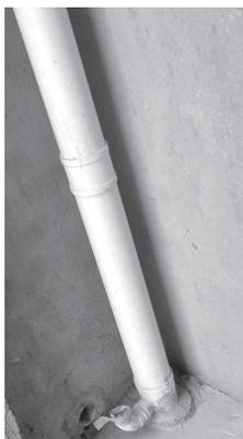
图1-21 水管没有加保护套(管)的工艺
