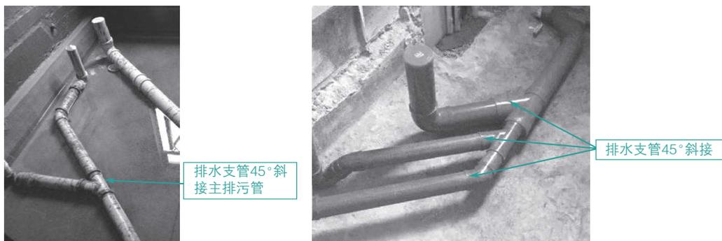
图1-33 排水支管45°斜接主排污管
