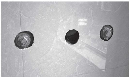
图10-7 卫生间墙面的贴砖工程注意水管附件高度
