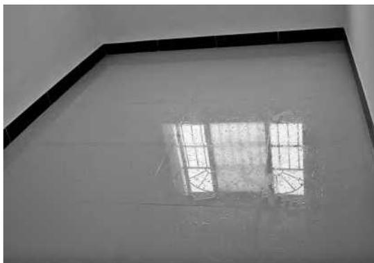
图11-8 地砖工程洒水养护
