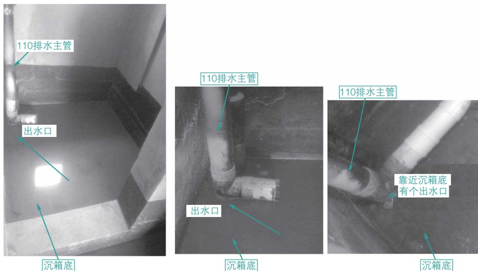
图1-44 底层排水出口（层）工艺的出发点与核心节点——靠箱底有个出水口
