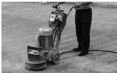
打磨机打磨施工
