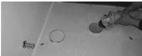
切割多余下的水管口
