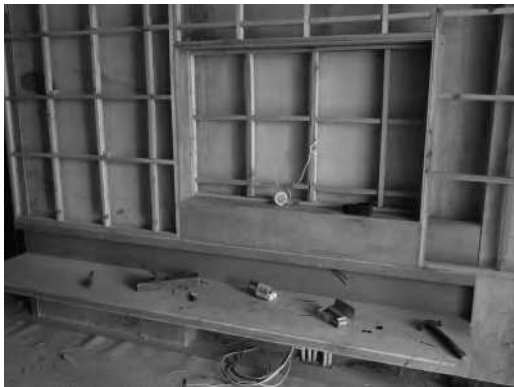
将框架安装牢固
