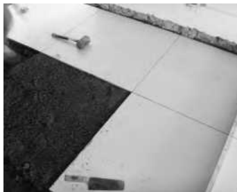
统一缝隙、调整平整度
