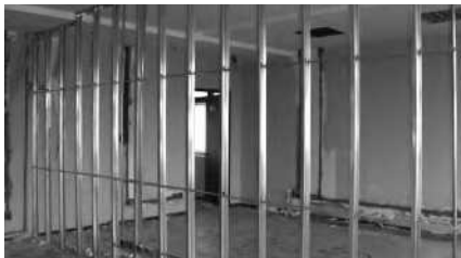
安装通贯龙骨
