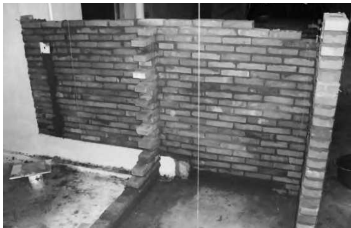
新砌筑墙体放竖线
