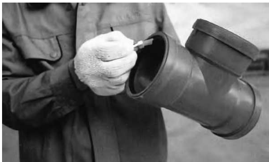
管口粘接面涂抹胶水
