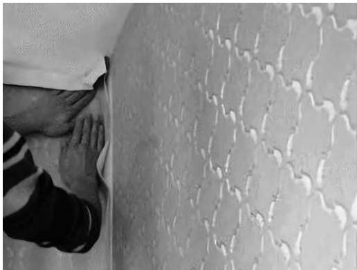
墙面阴角处理
