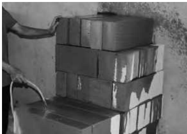
对砖体进行浇水
