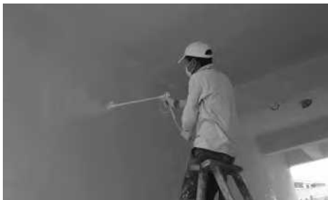
墙面喷涂施工
