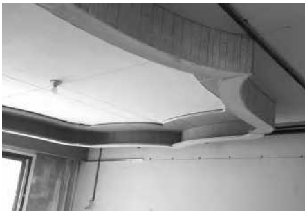
弧形曲面石膏板拼接工艺
