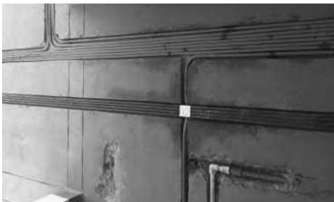
水平方向敷设多根穿线管
