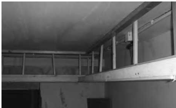
预留暗藏灯带灯槽
