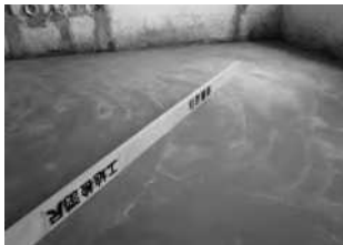
靠尺检查水平度
