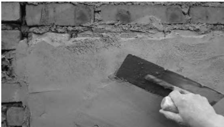
抹水泥砂浆层
