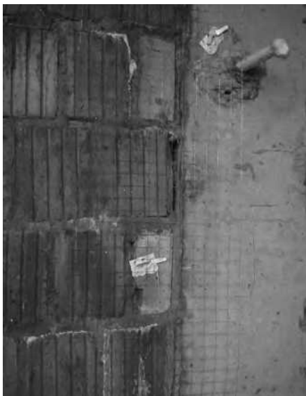
新旧墙体衔接处挂钢丝网
