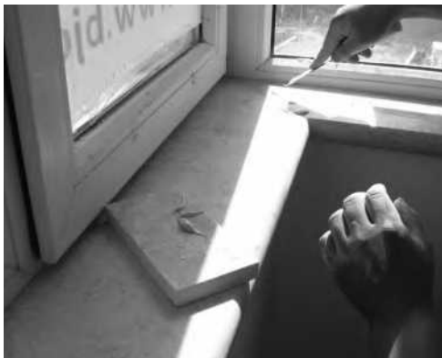
板材接缝处打胶
