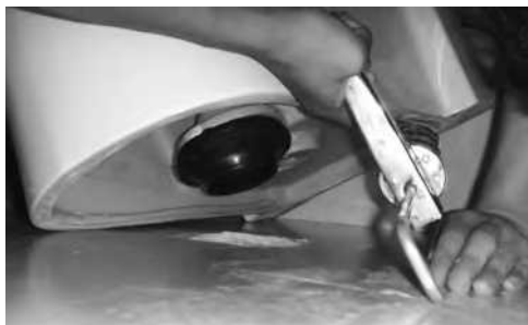
拆除坐便器底座
