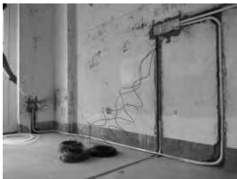
强电穿线施工
