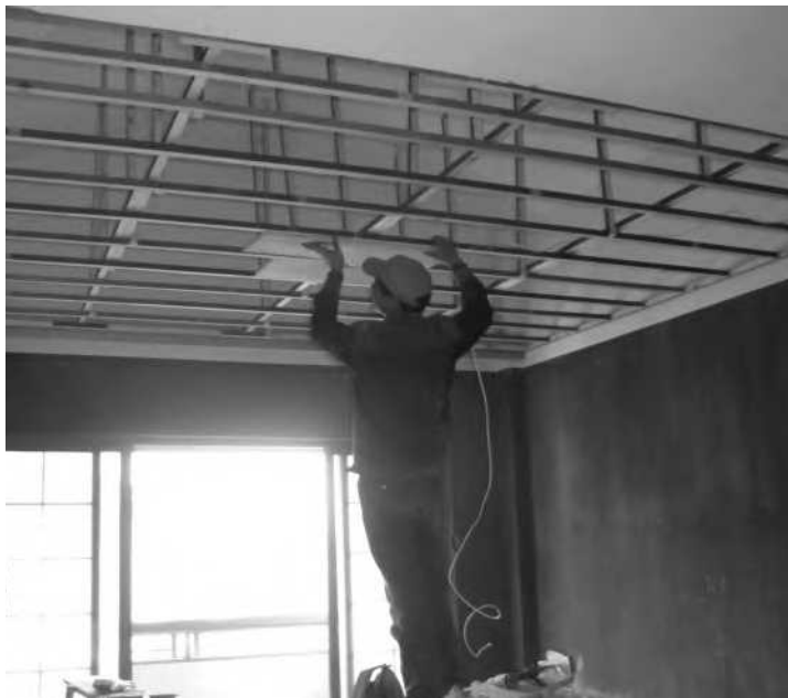
吊灯位置加固
