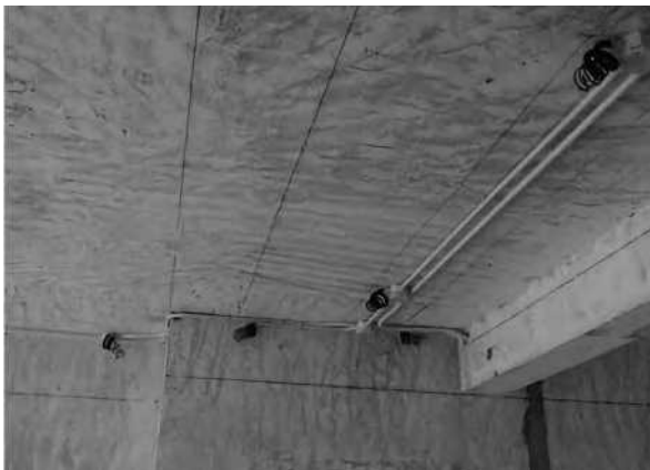
吊顶、墙壁边上弹基准线
