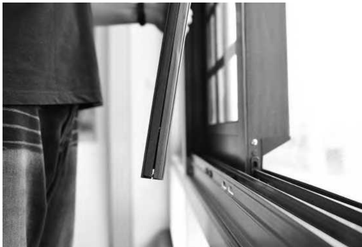
拆除推拉式窗扇
