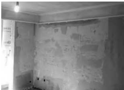
面层粉刷石膏找补
