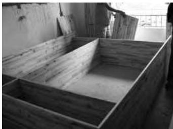
安装中间立板
