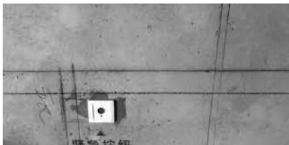
电路横向、纵向基准线
