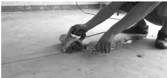
开槽机开槽施工
