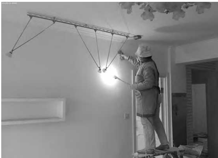
腻子打磨施工
