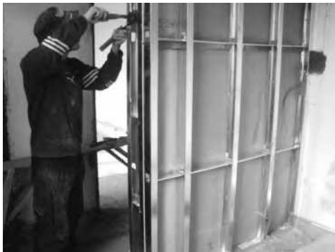
安装门口节点处骨架
