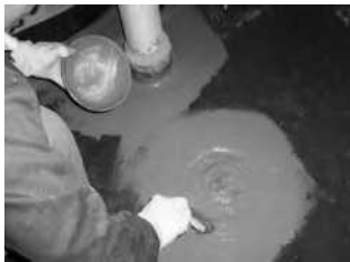
管件部位加固涂刷
