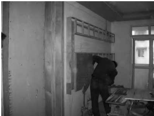
木骨架安装固定
