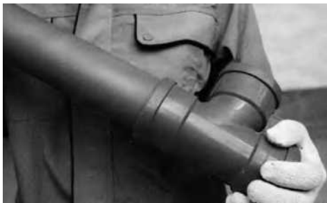
粘接管道和配件
