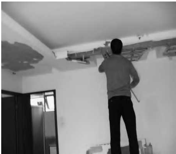
拆除石膏板吊顶
