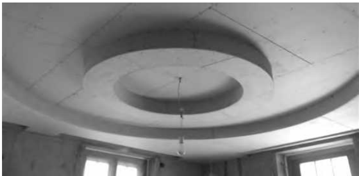
安装弧形曲面石膏板
