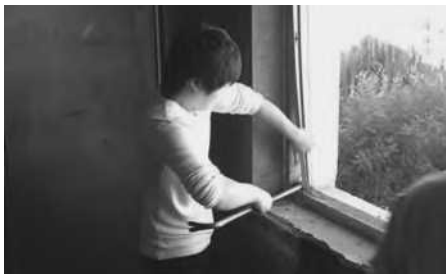
用撬棍拆除窗框架
