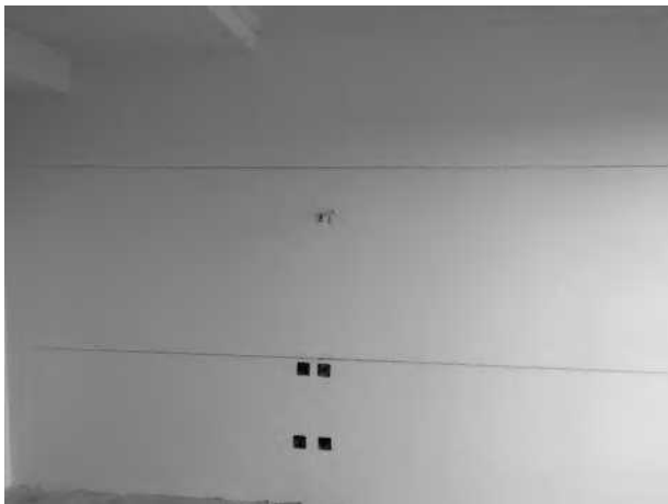
墙面水平线弹线标准
