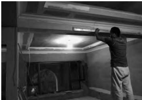
顶梁排刷施工
