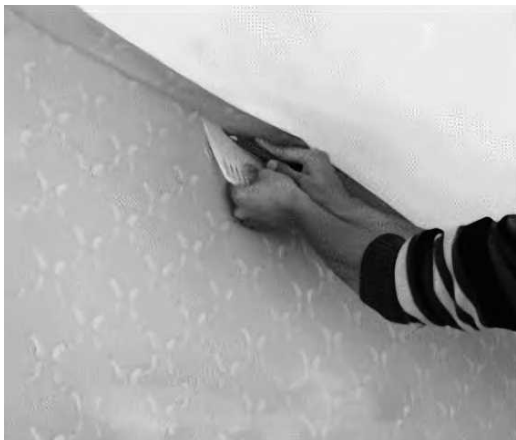
顶面阴角处理
