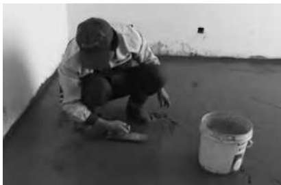
铺结合层砂浆
