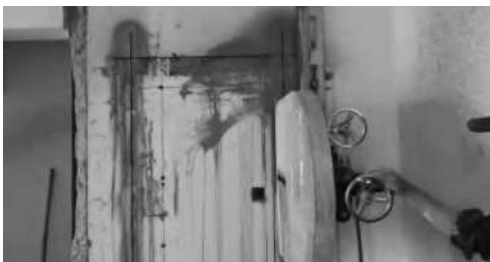
专业墙壁切割机作业
