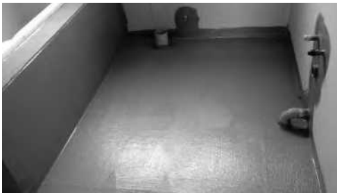
防水涂刷完成、养护
