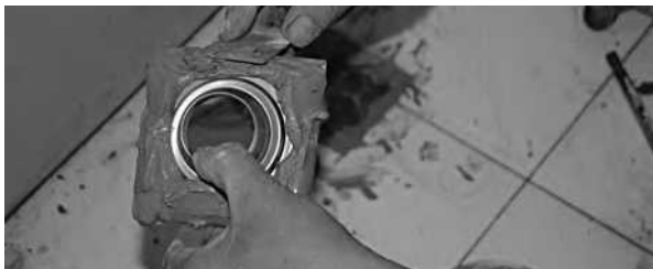
均匀涂抹水泥
