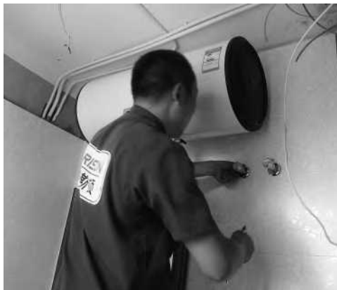
除热水器冷、热进水软管
