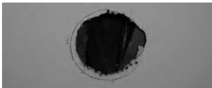
根据吊顶画线位置开孔
