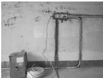
弱电穿线施工
