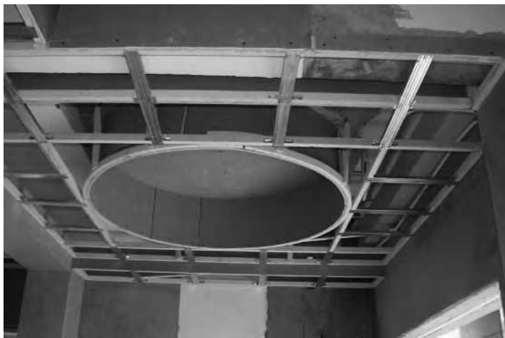
吊顶、墙壁边上弹基准线
