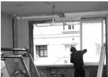
窗框架拆除施工
