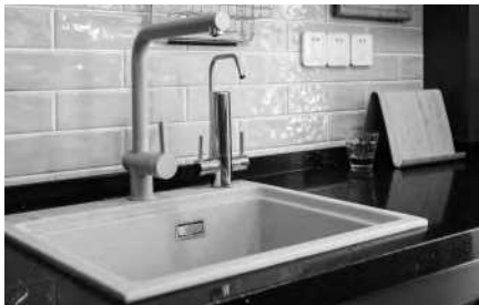
洗菜槽安装完成
