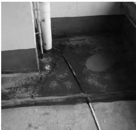
水泥砂浆挡水条
