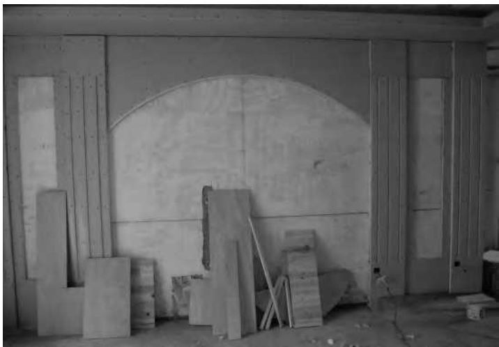
安装表面板材
