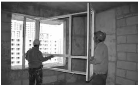
拆除下来完好的窗框架
