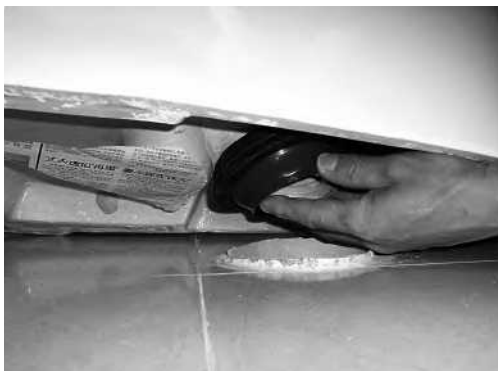
将法兰套到坐便器排污管上
