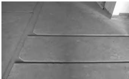
地面开槽 90° 处工艺处理
