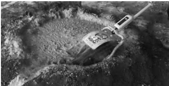
搅拌水泥砂浆
