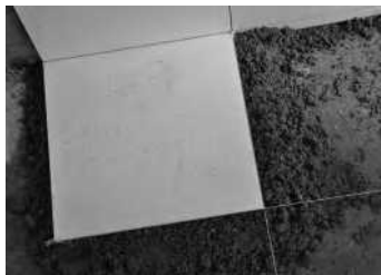
铺设定位砖、拉线
