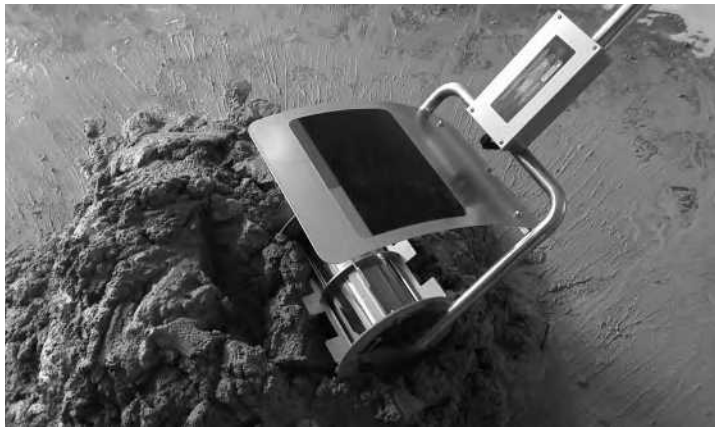
手持搅拌机搅拌水泥砂浆
