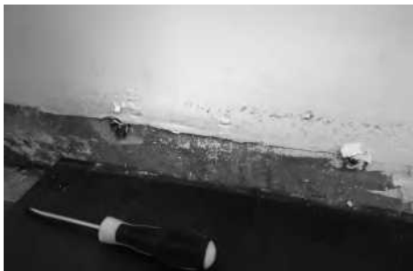
拆除踢脚线固定件
