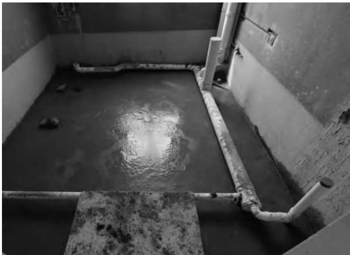
下沉式卫生间水泥抹平
