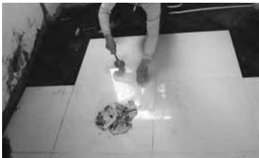
橡胶槌压平、拔缝
