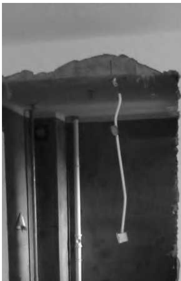
拆墙保留穿线管
