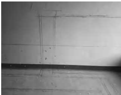
墙、地面电路弹线
