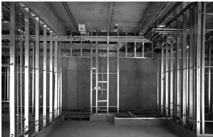
安装电路管线以及接线盒
