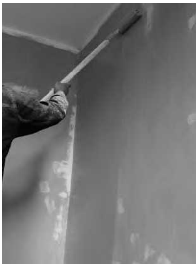
基层粉刷石膏找平
