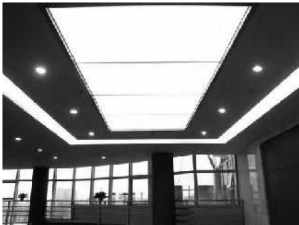
顶面采用软膜天花，使室内光均匀柔和
