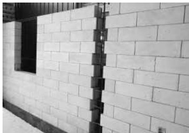
轻质砖砌筑的隔墙
