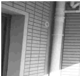
空调洞内外两侧安装装饰盖板
