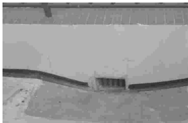
雨水篦子安装牢固,坡度合理
