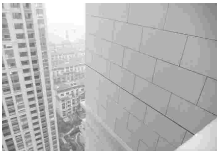
分隔缝采用成品塑料条或美纹纸，禁止采用手绘
