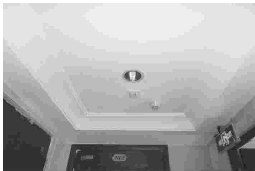
顶棚平整洁净，色泽均匀
