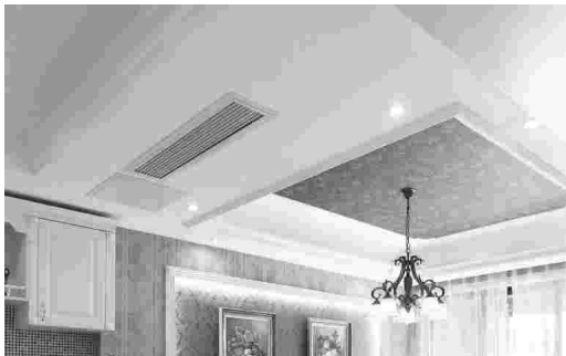
吊顶面平整, 无起拱、塌落及凹凸不平
