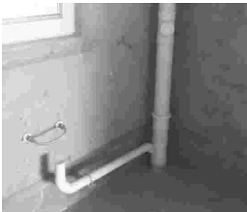
正确：排水管有向上弯头
