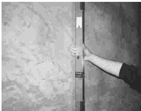
靠尺检测墙面平整度（二）
