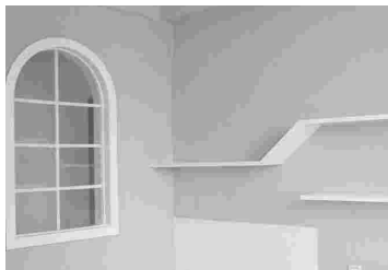
墙面整体无明显色差
