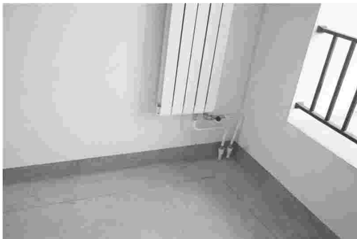
暖气片位置合理，安装牢固，表面无划痕
