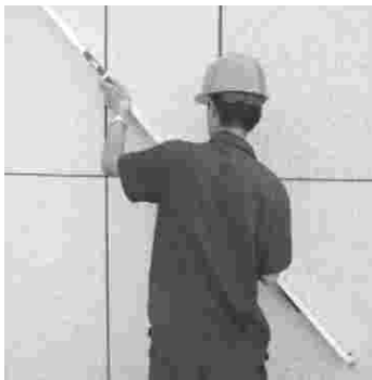
用 2m 靠尺检查墙面平整度
