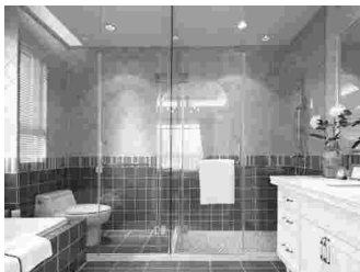
面层洁净无污物，无划痕，无色差，无缺棱掉角和裂缝
