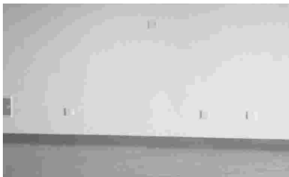
插座底部距地 0.3m，同一类型的插座高度一致
