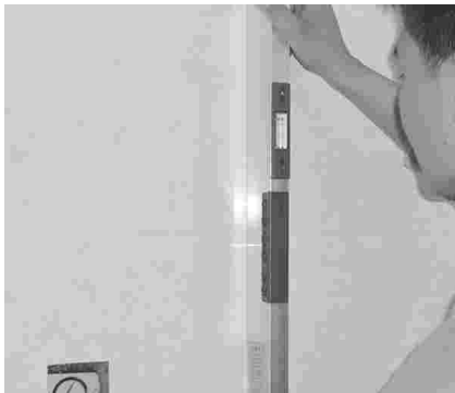
用靠尺检查平整度
