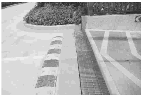
车库坡度入口处路面起坡
