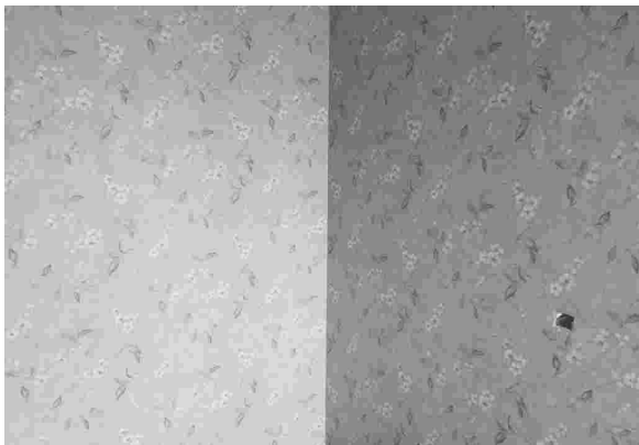
接缝平整、顺直，无色差
