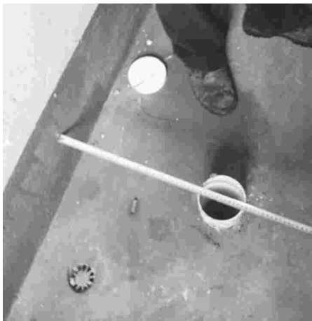
正确: 马桶预留排水管用与墙面距离符合要求
