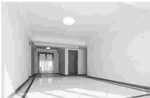
建筑顶面平整, 无起拱、塌落及凹凸不平
