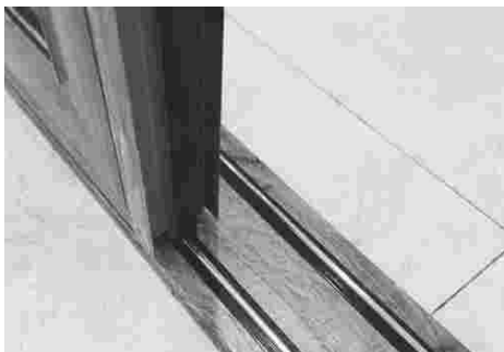
滑轨、滑道安装稳固，门扇推拉平顺，无异响
