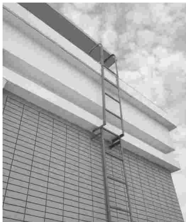
爬梯表面进行防锈及刷漆处理, 安装牢固
