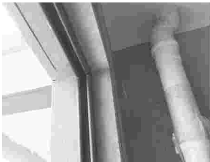
外窗楣滴水线不应到洞口侧面
