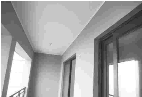
顶棚采用外墙涂料施工
