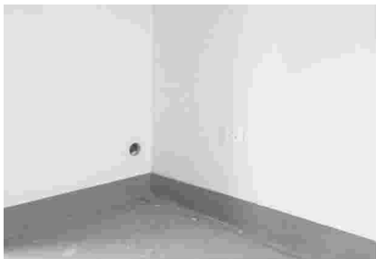
柜机空调洞中心距地面完成面 0.15m
