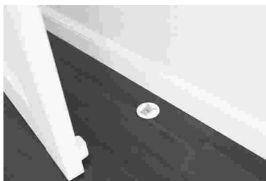
门吸安装、固定到位
