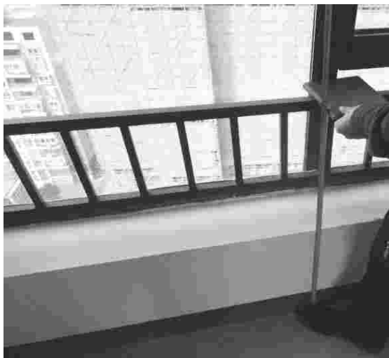
普通窗台上的护栏高度应符合要求
