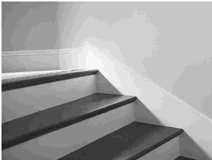
踢脚线与墙面结合紧密，阴阳角方正
