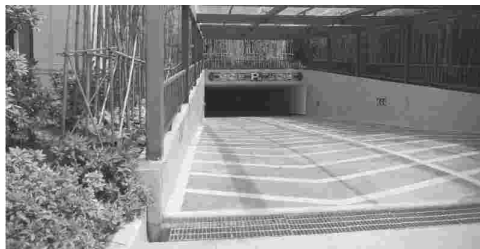
车库入口处地面截水沟完整贯通
