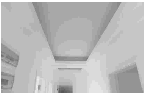
吊顶与墙面成 90^\circ 角
