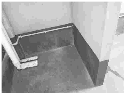
隔墙防水层高于完成面 300mm
