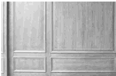
接缝平直，横竖缝隙宽度一致
