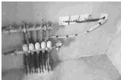
地采暖集分水器安装规整
