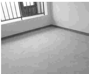
墙、地交接处的阴角方正顺直
