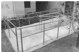
残疾人坡道的栏杆扶手设置上下两道
