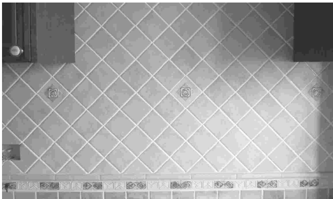
非整砖铺贴部分排列平直
