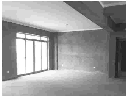
灰墙墙面平整, 无空鼓、起砂和裂纹
