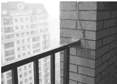
阳台护栏墙面盖板固定牢固
