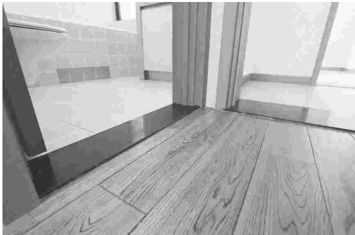
卫浴间门口安装挡水条
