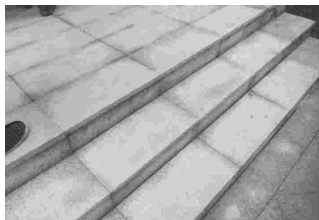
单元门出入口外台阶踏步高度及宽度满足要求
