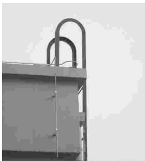
避雷带在转角处做圆弧圈
