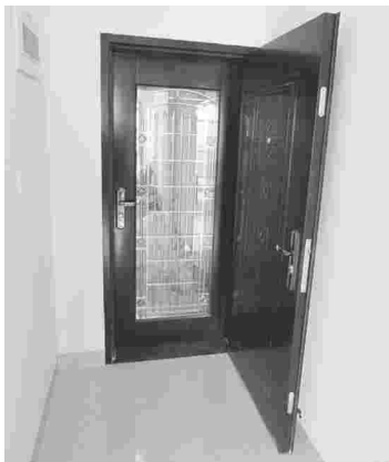
正确：入户门开启后后方无消防箱等设备
