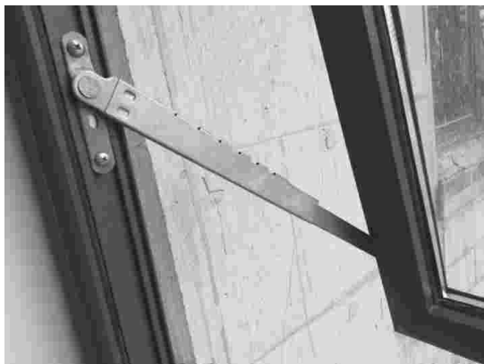
外悬窗开启距离大于 300mm 应设限位器
