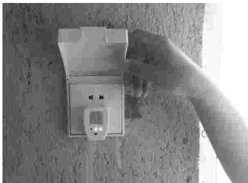
观察指示灯，即可判断接线正确与否
