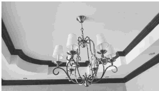
超过 1kg 的灯具应设置吊链
