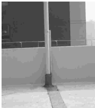
套管封堵密实, 无渗漏
