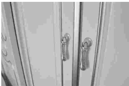
把手安装牢固，同排拉手水平
