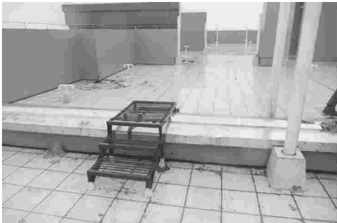
上人屋面变形缝处设置台阶(一)
