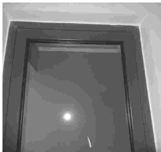
关闭后扇与框型材的内外表面宜平齐
