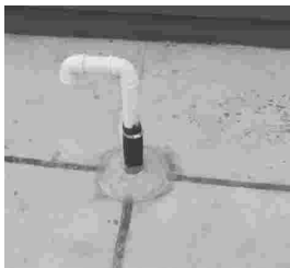
管道根部防水卷材采用套箍固定
