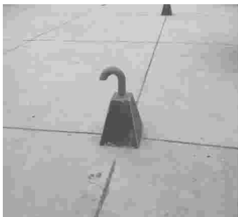
引气管周边做加固措施
