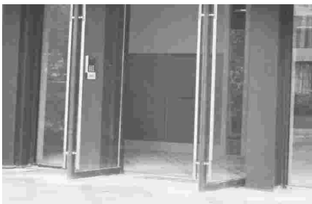
大堂门室内外地面有高差, 且用坡度过渡
