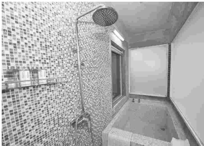
混水阀距地面的高度一般为 900 ~ 1100mm
