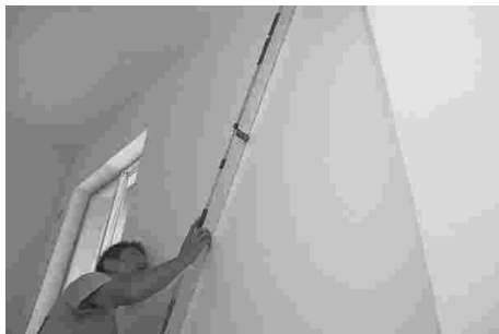
靠尺检测墙面平整度（一）
