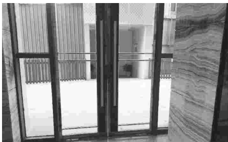
门扇不宜过大，在人视线高度设警示线条
