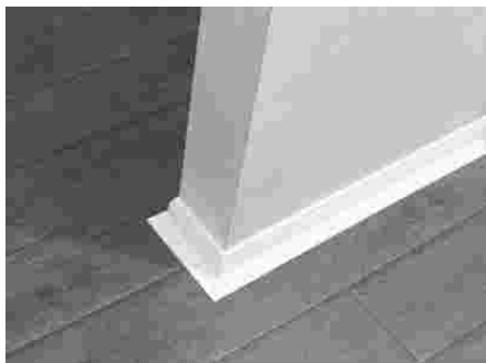
无划痕、变形、凹凸、缺损等缺陷
