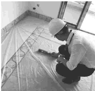
利用靠尺检测地砖的平整度
