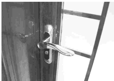
门拉手安装、固定到位
