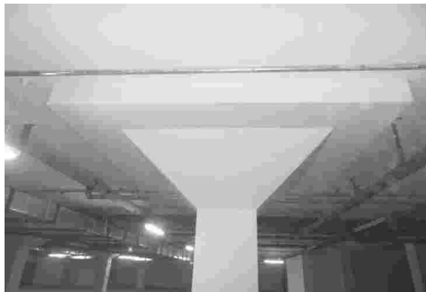
顶棚无漏水和明显湿渍
