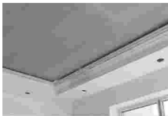
吊顶房间可检查中间建筑顶棚的位置
