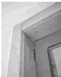
门套与墙之间的缝隙用 发泡胶双面密封
