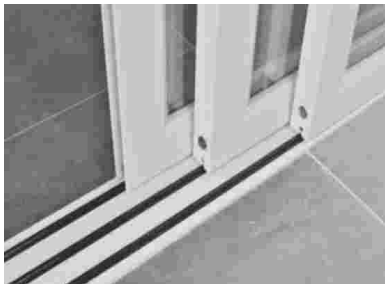
压条与型材的接缝处没有明显的缝隙
