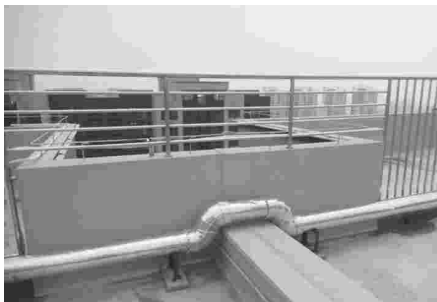
女儿墙每隔 12m 应设伸缩缝
