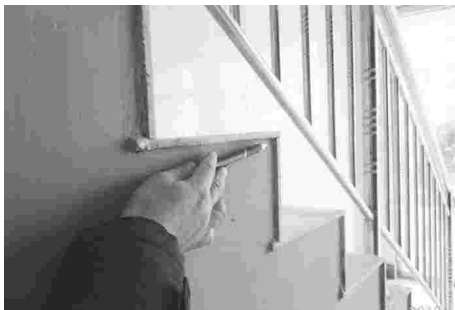
无止水台时大理石饰面突出踏步侧面
