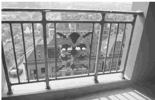
长护栏在中间做加强护栏刚度的措施
