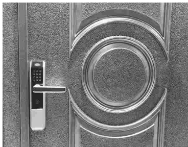
漆面无漏刷、流坠等问题
