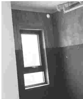
卫浴间墙面防水翻到窗户洞口侧边至窗框处
