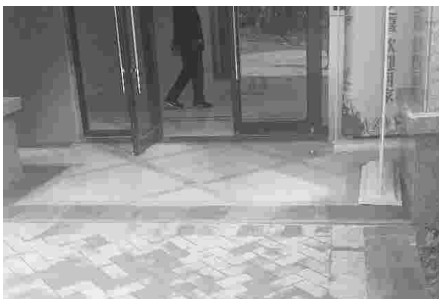
地面有坡向汇水区的坡度
