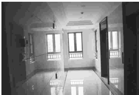
装饰平整、线条顺直，无明露管线
