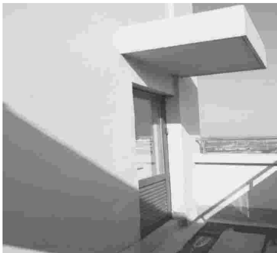
屋面出入口处设置雨篷，高度合理
