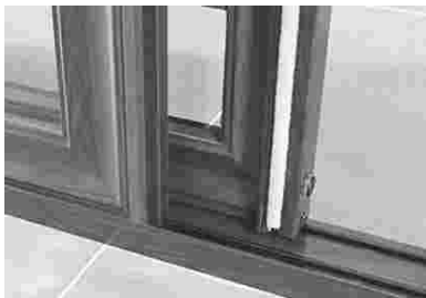
密封条与玻璃槽口的接触平整
