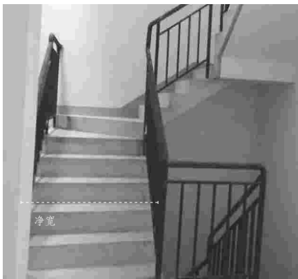
两侧有墙体的楼梯净宽测量示意
