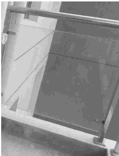
阳台护栏底部盖板固定牢固
