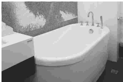
浴缸安装应完全水平
