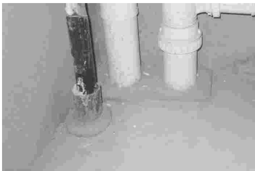
厨房天然气套管填塞符合要求
