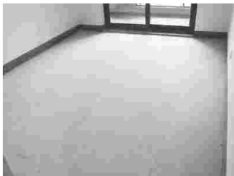
地面平整、洁净，无色差及明显接茬
