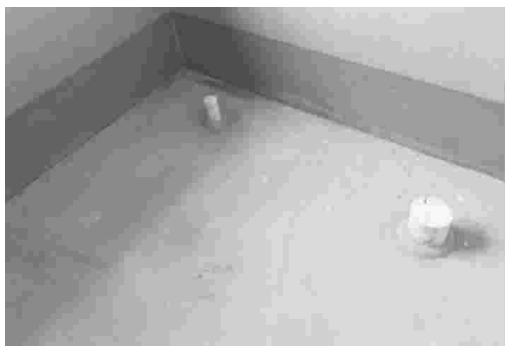
防水保护层平整、洁净，无裂纹、起砂
