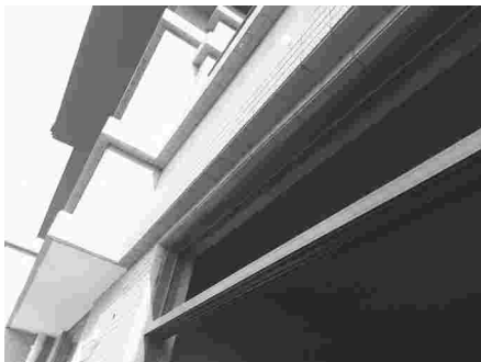
线条上表面面砖向外有坡度铺贴
