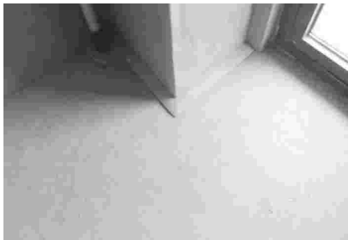
地面平整，无裂纹
