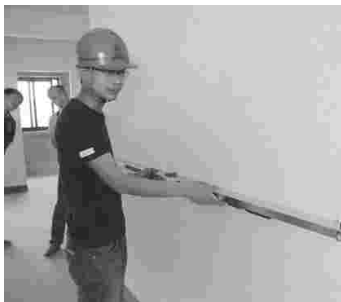
用靠尺检查墙面平整度
