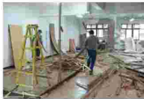
清运废弃物要注意人员安全
