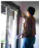
铝门窗框架设好，收边缝要灌进了防水剂的水泥，边缘补好再做细部的泥作修补。
