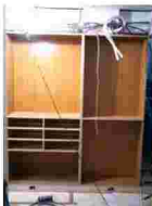
木作柜下方记得要预留出线孔
