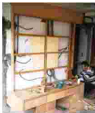
壁面木工，在悬挂电视机的位置注意加强支撑
