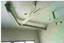
过板侧吊式排水管配置
