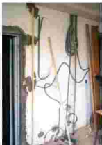
墙面木工动工前，要经过的电线、信号线等都要设置完成
