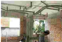
过板侧吊式排水管配置
