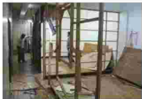
拆除隔间前要先确认墙面种类，木作隔间墙通常可拆除
