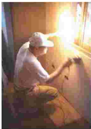
使用灯泡打光，在磨砂的过程中确认平整度
