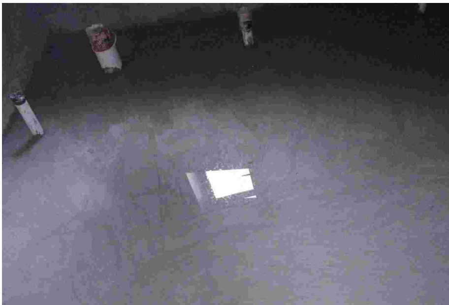
图 1-15 卫生间闭水试验
