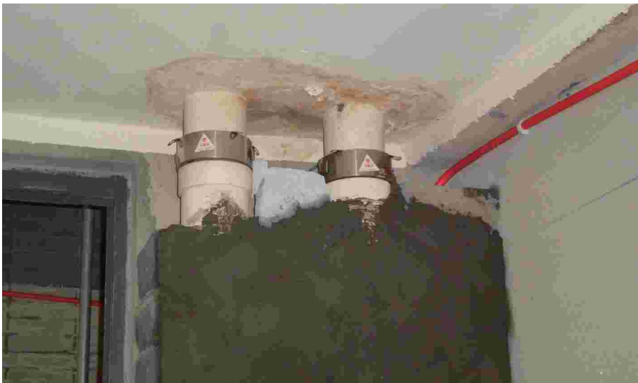
图 4-21 包砌落水管
