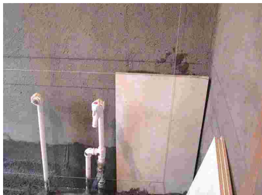
图 4-50 找准水平及垂直控制线
