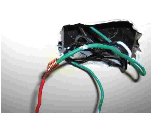
图 5-26 绑扎电线
