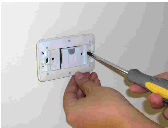
图 5-23 拆卸螺丝
