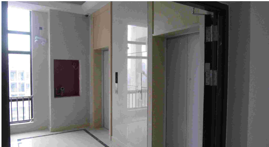
图 1-8 整洁的电梯间
