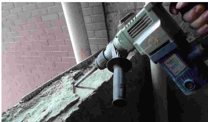
图 4-15 用电锤小心拆除墙体外部饰面材料
