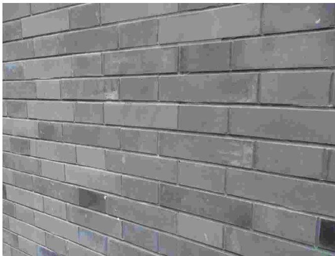
图 3-52 粉煤灰 砖砌墙
