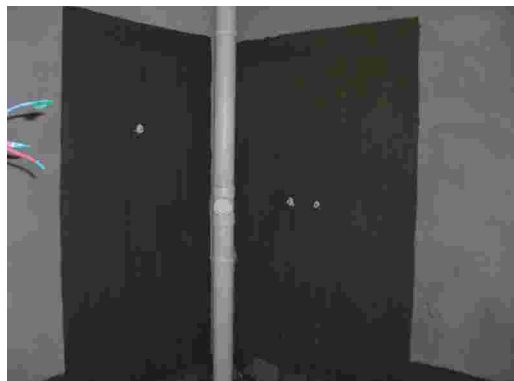
图 4-41 淋浴区墙面涂刷
