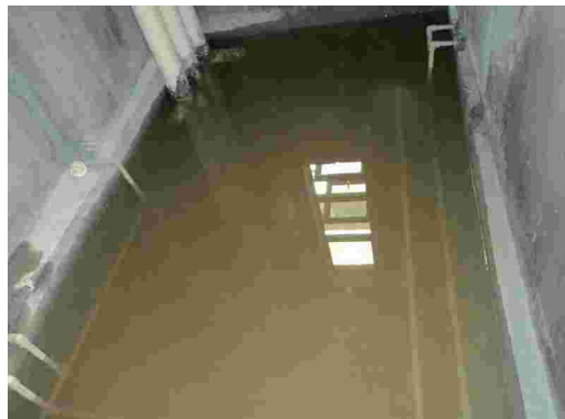
图 4-39 灌水试验
