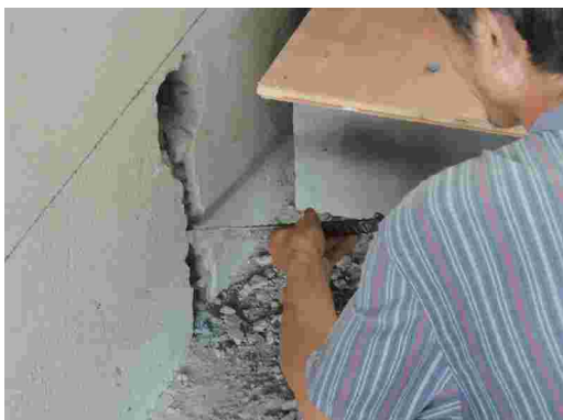
图 4-30 在墙上开槽
