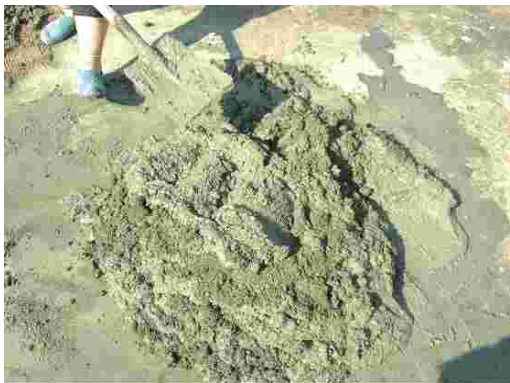
图 4-60 水泥砂浆要在凝结成块前用完
