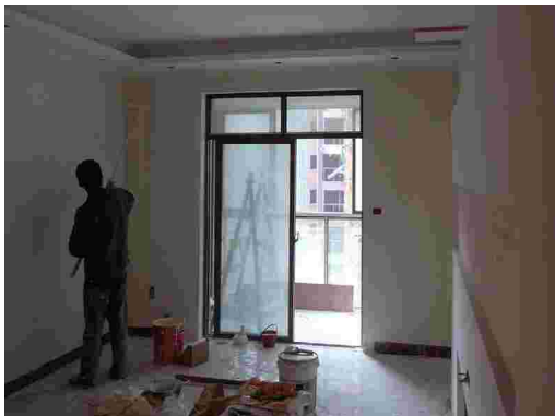
图 4-61 乳胶漆涂刷于墙面
