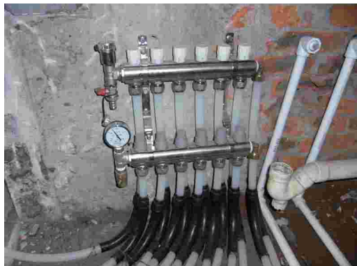
图 4-34 分集水器安装在指定位置
