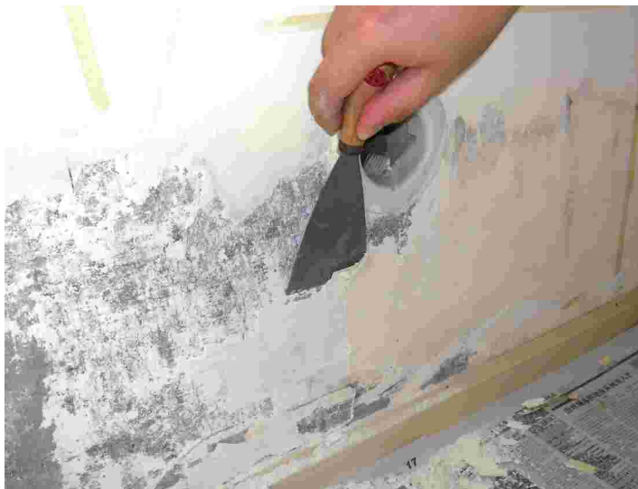
图 5-35 铲除 起泡墙面
