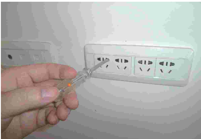
图 4-67 用电笔测试插头是否有电
