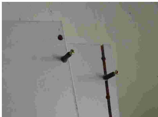
图 4-71 连接件固定柜体
