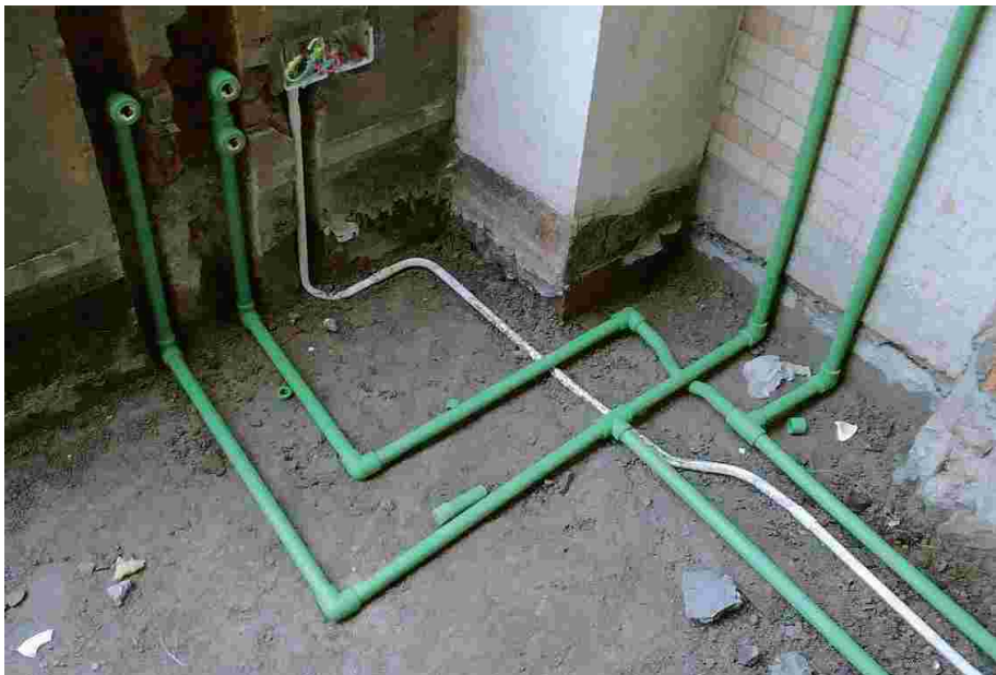
图 3-16 铜塑复合管铺装应用
