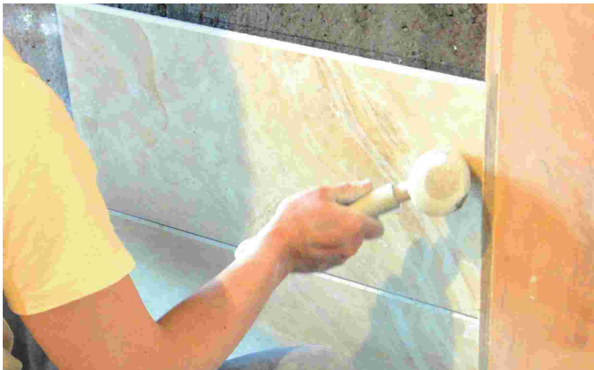
图 4-51 橡皮锤敲击
