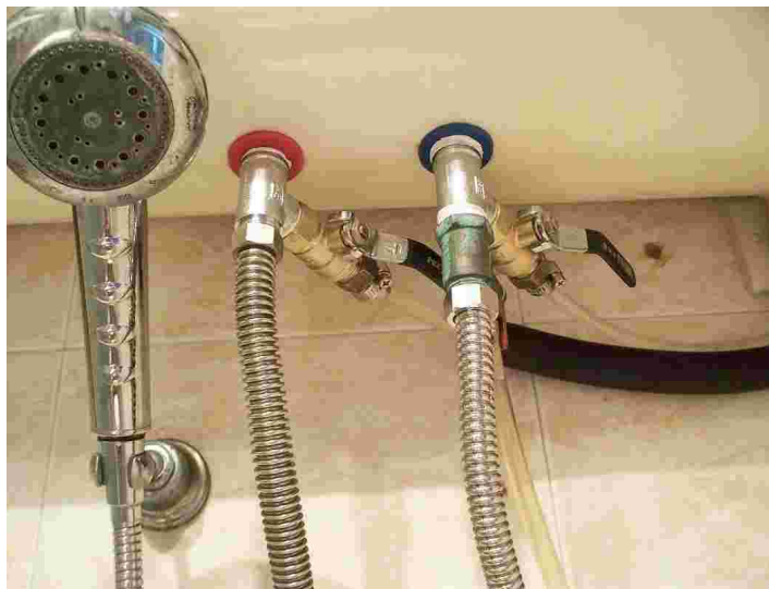
图 3-22 不锈钢波纹管的应用
