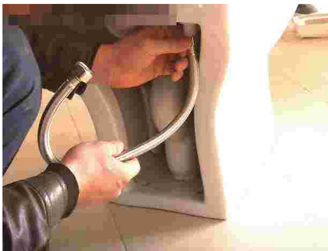
图 5-22 安装软管
