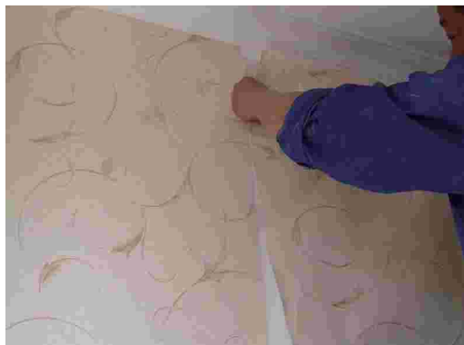
图 4-66 拼接壁纸使图案吻合
