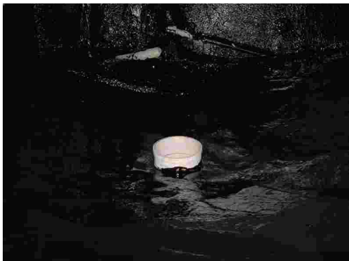
图 4-40 排水管边缘涂刷
