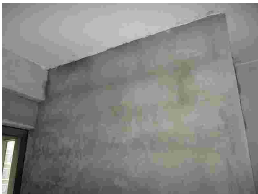
图 4-19 补砌墙体抹灰
