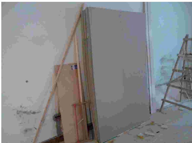
图 4-8 板材 依靠墙面放置
