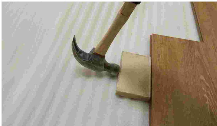
图 4-58 敲击 安装垫块
