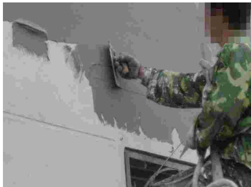
图 4-59 对墙面抹灰养护
