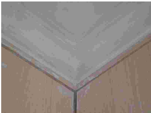
图 4-63 石膏线条安装
