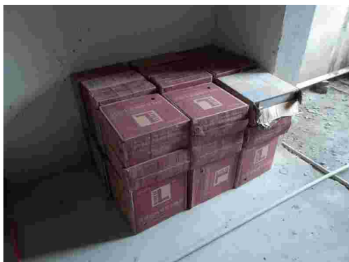
图 4-9 墙地砖靠墙码放
