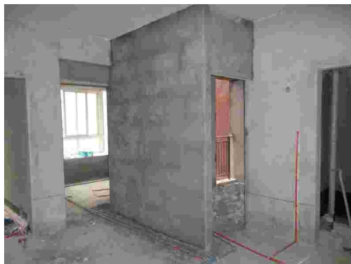
图 4-20 补砌墙体完成
