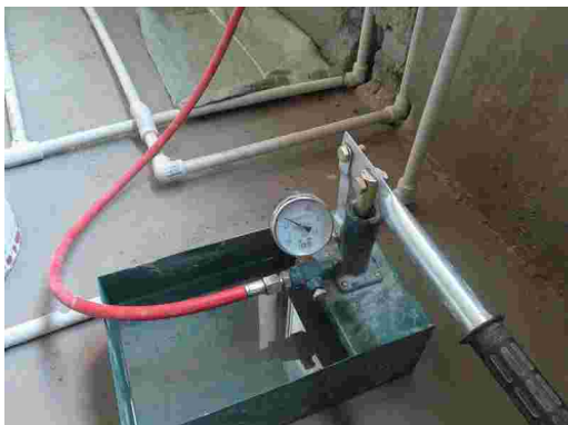
图 4-25 打压器给水管试压
