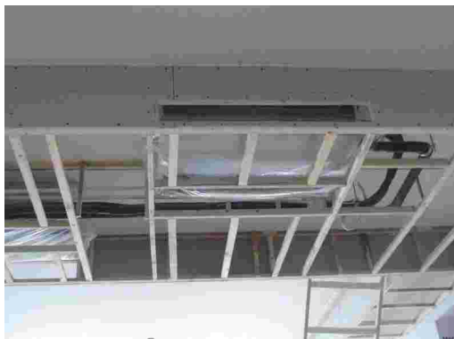
图 4-79 制作木龙骨吊顶
