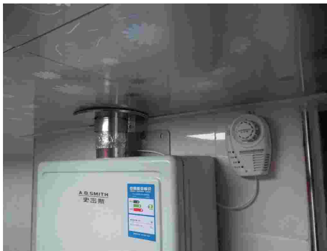
图 4-75 安装报警器和烟囱
